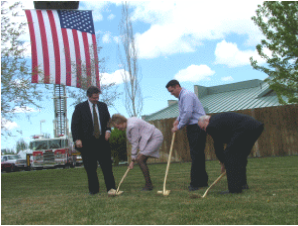
The first Dig
